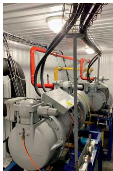
Рис. 3. Низкотемпературная водоохлаждающая установка (чиллер) контейнерного типа на базе винтовых компрессоров Fusheng. Производство ООО «РЕФТЭК», Москва
